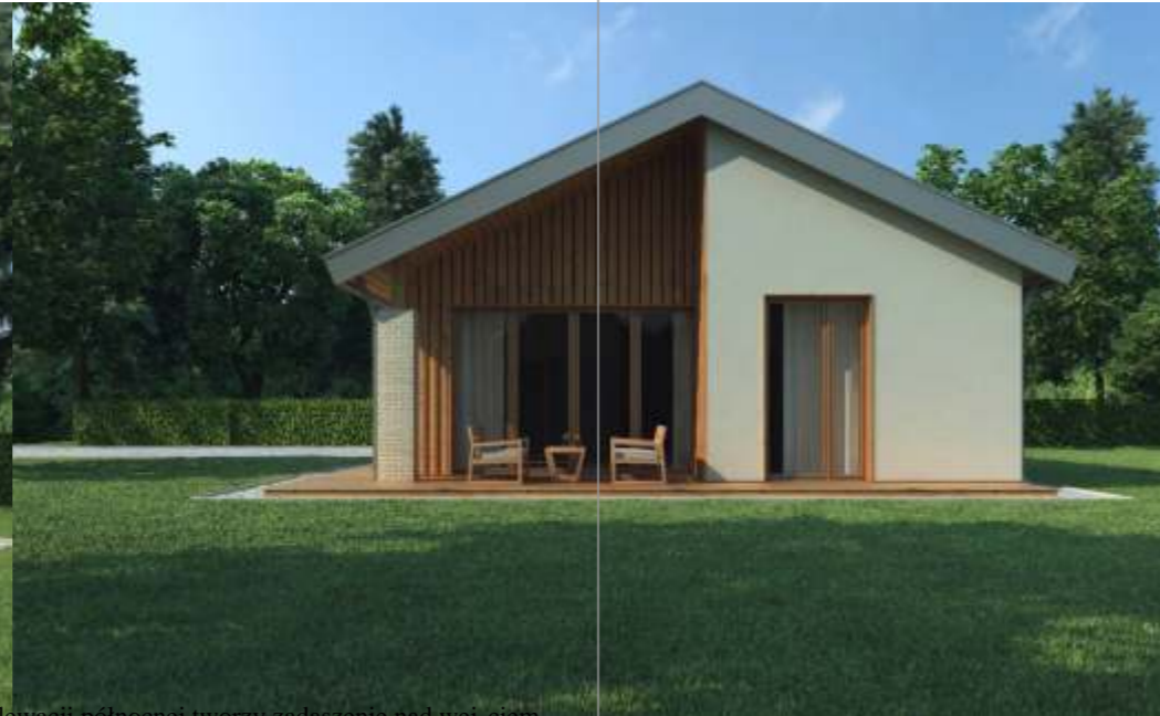
Podciecie na elewacji północnej tworzy zadaszenie nad wejściem. Antystłup.....
